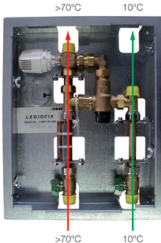
ГЕРЦ LEGIOFIX - РЕЖИМ ТЕРМИЧЕСКОГО ОБЕЗЗАРАЖИВАНИЯ ОТ ЛЕГИОНЕЛЛ
